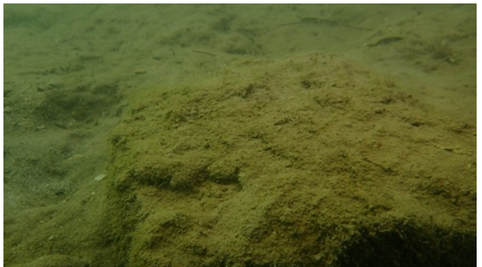
Figure 1 : Fond vaseux entre le pont SNCF et le pont routier 1/2
